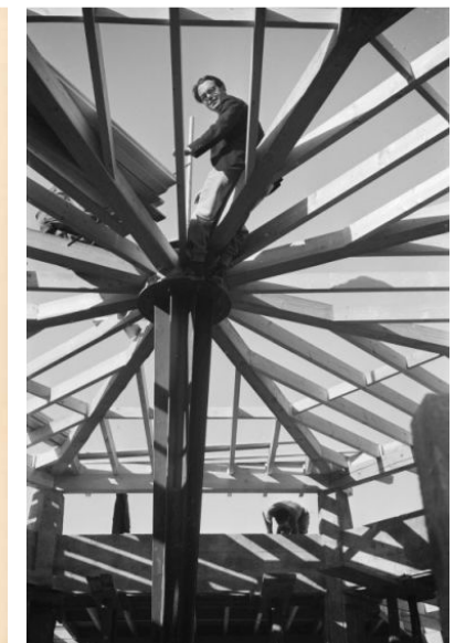
Räume voll Himmel - MF auf dem Rohbau des Pavillons seines Letzibades in Zürich
